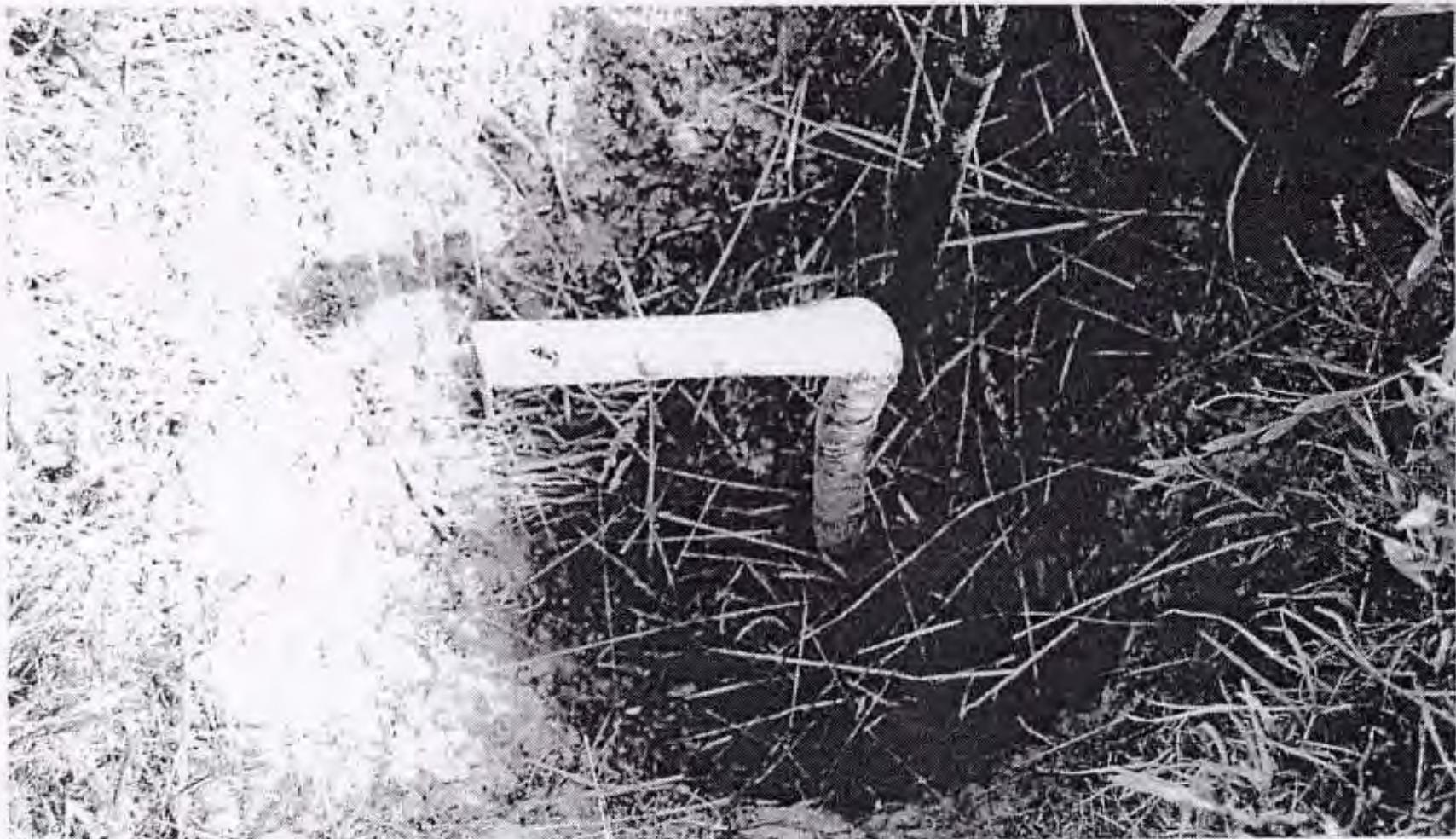
PTB/Fig. 32A: ground stud 1 inch copper
